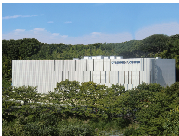
図 2: IT コア棟の外観。
