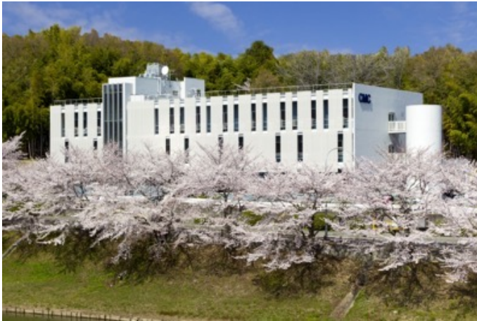
吹田CMC 本館
