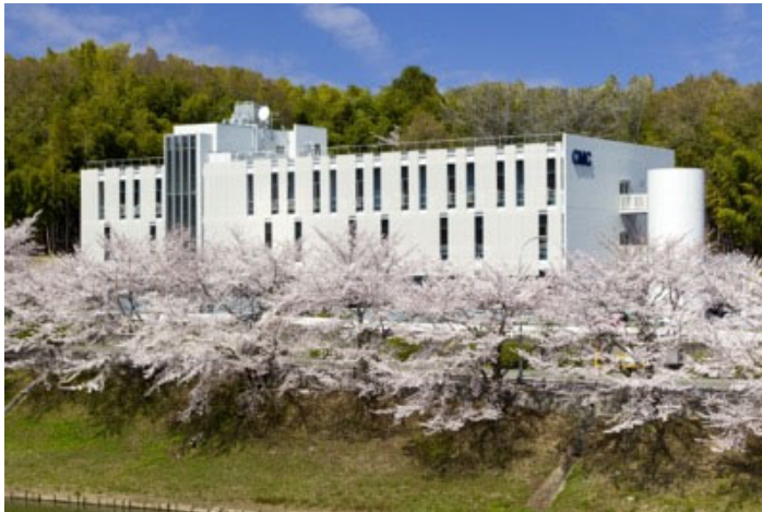
吹田CMC 本館
