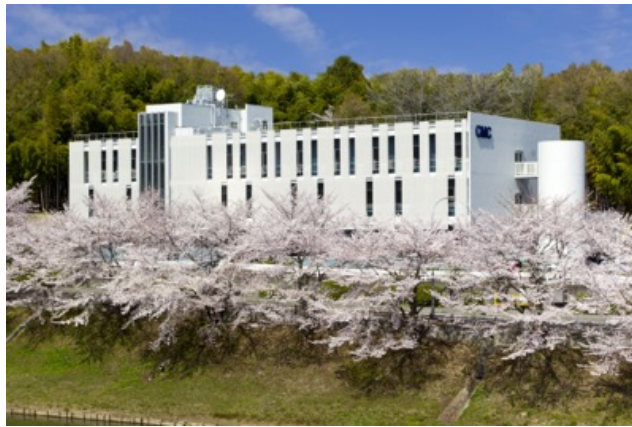
吹田CMC 本館
