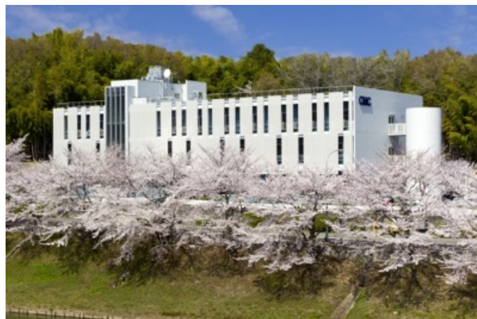
吹田CMC 本館
