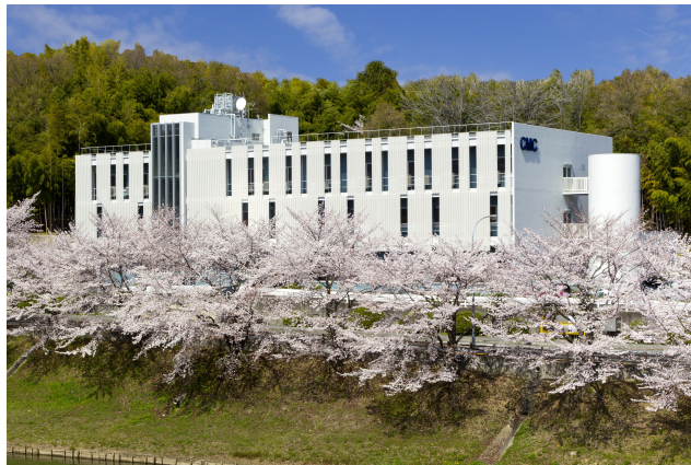
吹田CMC 本館
